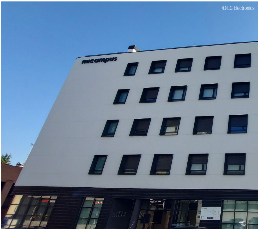
Hauptfassade des Gebäudes Micampus MT14. Micampus MT14: Principal facade of the building.
